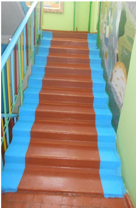
Лестничная площадка 2 этаж
